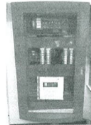
๑. FACP สัญญาณที่เชื่อมกับเครื่องเตือน
